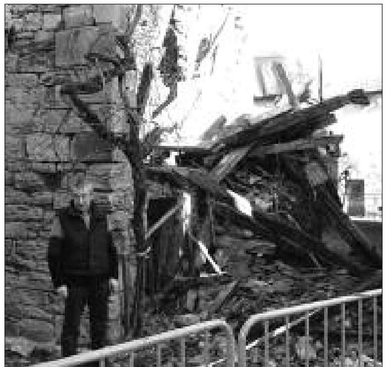
Christian Bouyssou, un voisin, est venu constater les dégâts
